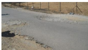
fig.4 Edge crack
