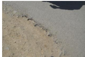
Fig.7 Edge crack
